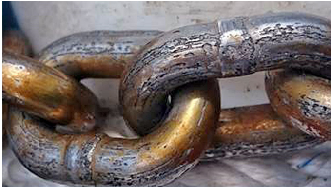
An dieser Edelstahlkette hat eine starke anodische Korrosion stattgefunden. ©cromox
